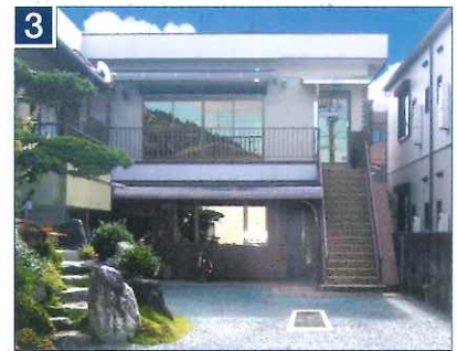
3 埋め戻し、施工完了。
