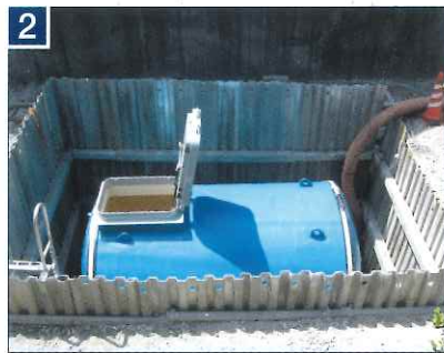
2 タンクバンドで固定後、出入り口となる完全防水ハッチの取り付けを行います。
