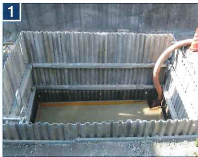
1 庭や駐車場などを小型重機で掘削し水平にコンクリート基礎を打ちます。
